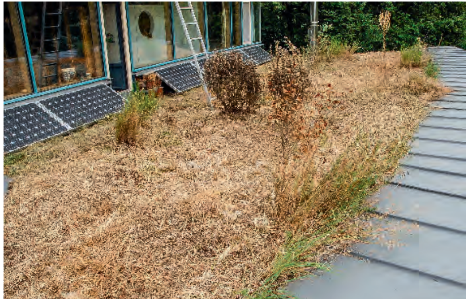
Wenn das Dach so vertrocknet, scheint alles verloren.
