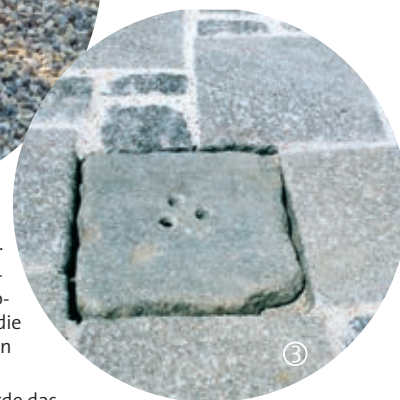
(3) Der Gully wurde versteckt. Daher wurde das Pflasterniveau etwas höher angesetzt. Die Abdeckung erfolgt durch eine lose Stein-platte aus demselben Material.
