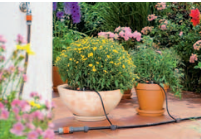
Eine elegante Hilfe angesichts intensiver Pflegebedürfnisse: eine Bewässerungsanlage
