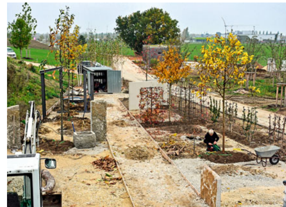
Blick von der Dachterrasse des Pavillons in den stetig wachsenden Lehrgarten. (Aufnahme im Oktober 2019)
