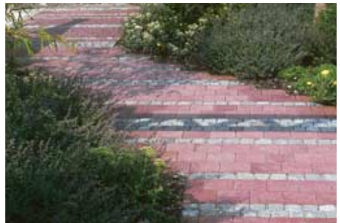
Ein breiter Weg mit engfugig verlegtem Klinker im Wechsel mit Granit lässt sich gut begehen und befahren.
