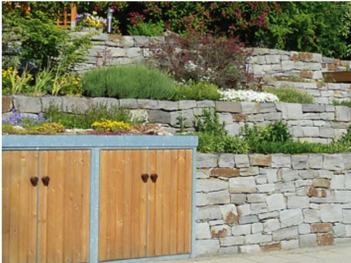
Der Mülltonnenschrank wurde in eine Trockenmauer aus Naturstein integriert.
